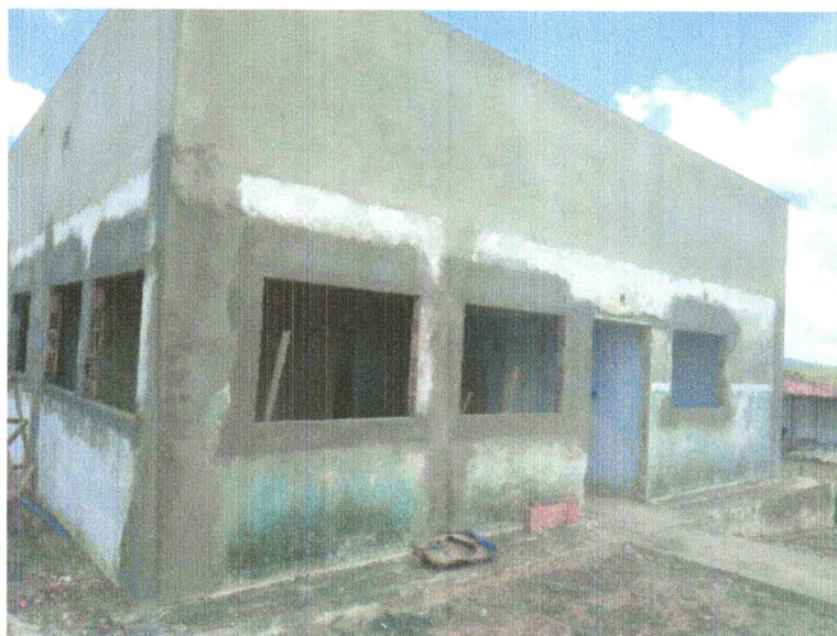
FOTO 15 - (COMPOSIÇÃO REPRESENTATIVA) EXECUÇÃO DE ESTRUTURAS DE CONCRETO ARMADO, PARA EDIFICAÇÃO HABITACIONAL UNIFAMILIAR TÉRREA (CASA EM EMPREENDIMENTOS) FCK=25MPA. AF_01_01/2017
