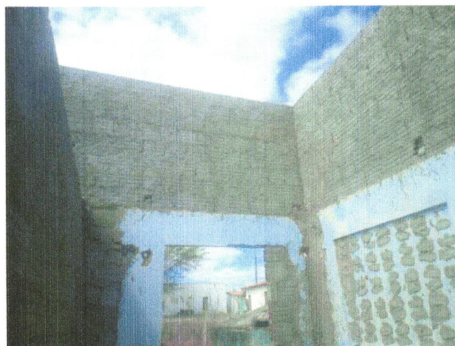
FOTO 01 – CHAPISCO APLICADO EM ALVENARIA (COM PRESENÇA DE VÃOS) E ESTRUTURAS DE CONCRETO DE FACHADA, COM EQUIPAMENTO DE PROJEÇÃO. ARGAMASSA TRAÇO 1:3 COM PREPARO EM BETONEIRA 400 L. AF_06/2014
