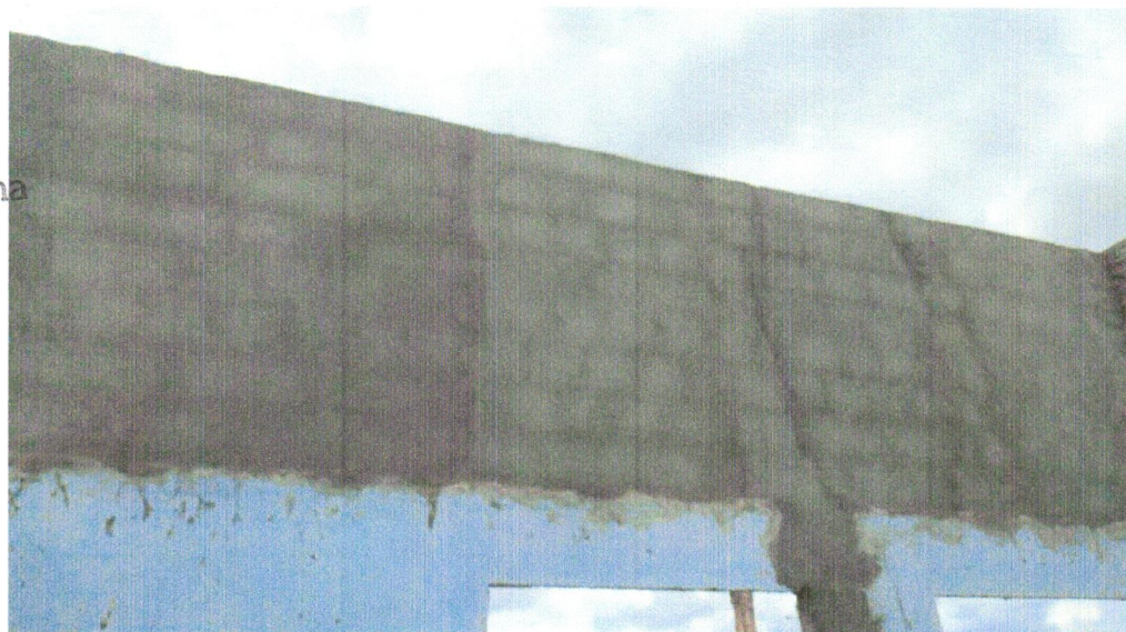
FOTO 05 – MASSA ÚNICA, PARA RECEBIMENTO DE PINTURA OU CERÂMICA, ARGAMASSA INDUSTRIALIZADA, PREPARO MECÂNICO, APLICADO COM EQUIPAMENTO DE MISTURA E PROJEÇÃO DE 1,5 M3/H EM FACES INTERNAS DE PAREDES, ESPESSURA DE 5MM, SEM EXECUÇÃO DE TALISCAS. AF_06/2014
