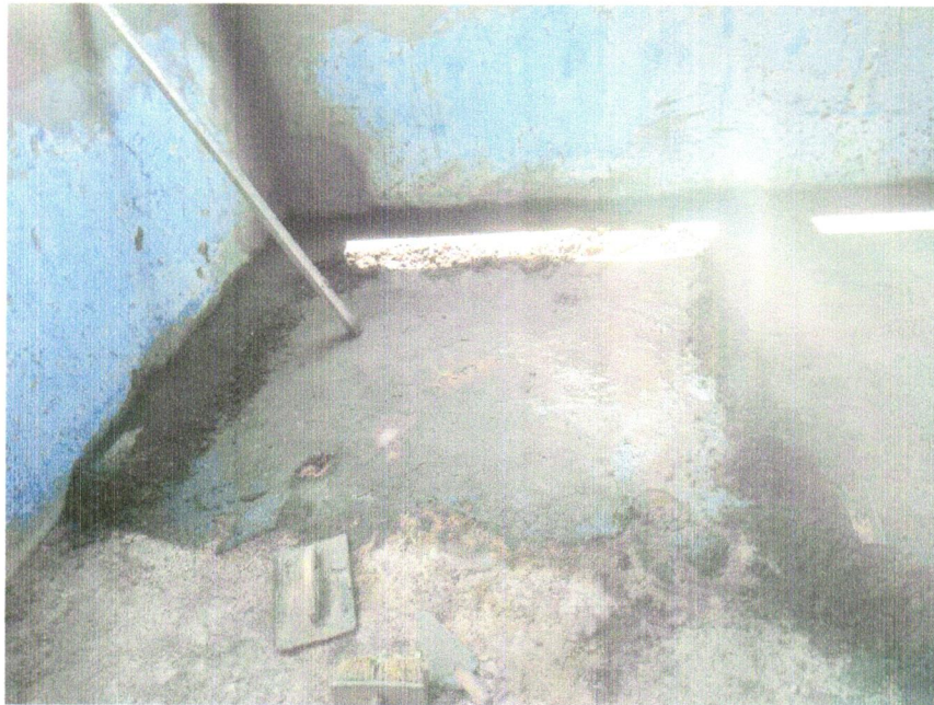
FOTO 18 – Contrapiso em argamassa traço 1:4 (cimento e areia), preparo mecânico com betoneira 400l, aplicado em áreas secas sobre laje, não aderido, acabamento não reforçado, espessura 5cm. Af_07/2021
