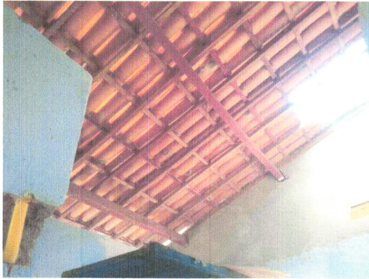
FOTO 13 - Retelamento em cobertura com telha ceramica tipo canal comum, Itabaiana ou similar.
