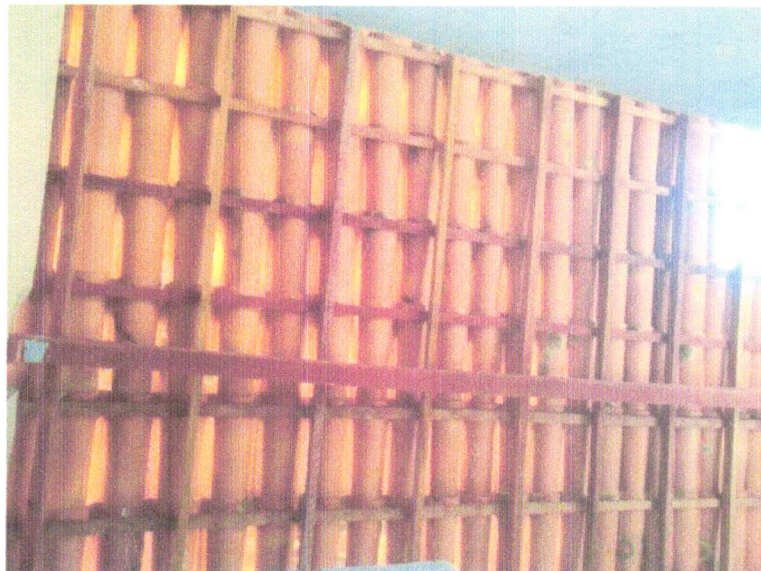
FOTO 14 – TELHAMENTO COM TELHA CERÂMICA CAPA-CANAL, TIPO COLONIAL, COM ATÉ 2 ÁGUAS, INCLUSO TRANSPORTE VERTICAL. AF_07/2019
