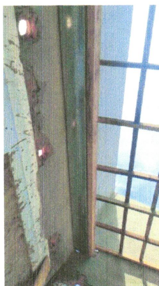
FOTO 02 – - CALHA EM CHAPA DE AÇO GALVANIZADO NÚMERO 24, DESENVOLVIMENTO DE 33 CM, INCLUSO TRANSPORTE VERTICAL. AF_07/2019
